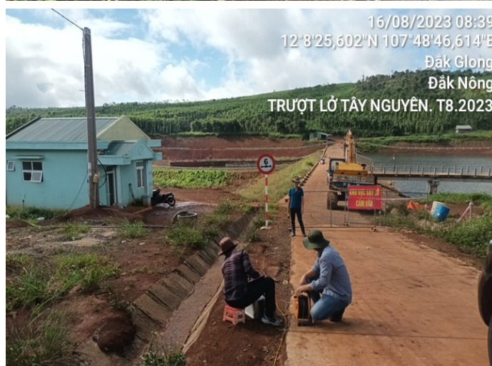
Tiến hành đo địa vật lý tại một số khu vực trọng điểm
