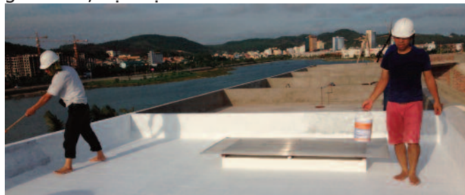
Thi công sơn lớp sơn nanocompozit acrylic/R-TiO 2
