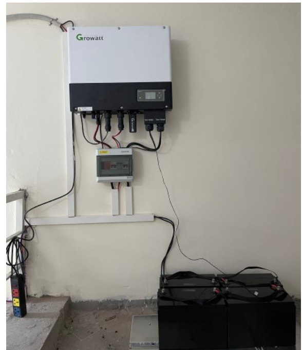
Hình 10. Thử nghiệm hoạt động trạm sạc điện dùng điện mặt trời trong điều kiện thực tế tại Viện Khoa học Năng lượng
