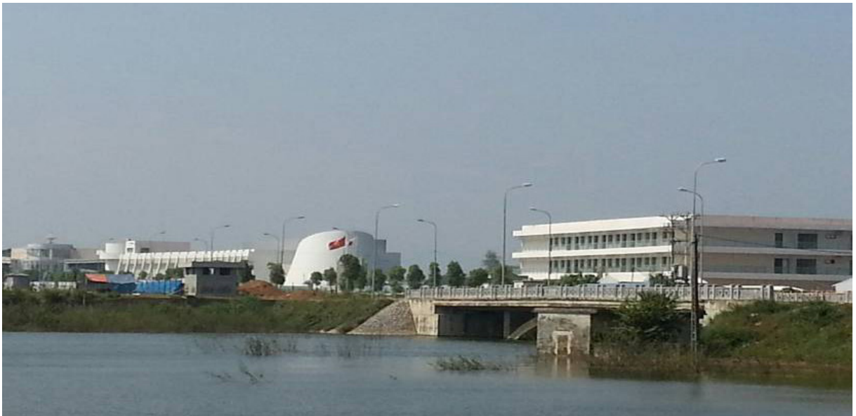
Cơ sở Trung tâm Vũ trụ Việt Nam tại Hòa Lạc
