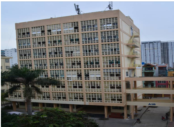
Sửa chữa, cải tạo nhà A18 Viện Hóa học
