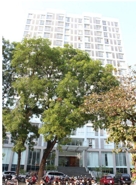
Tòa nhà ươm tạo công nghệ
