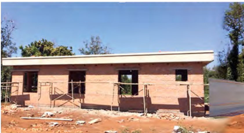
Khu đất 5ha của Viện Hàn lâm KHCNVN tại Thành phố Buon Ma Thuot (vài hình ảnh về XD hàng rào + nhà bảo vệ - làm việc)
