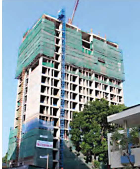
Công trình Khu ươm tạo công nghệ (đã xong phần thô đến tầng 17)
